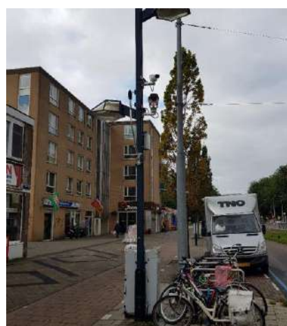
Meetpost rijbaan richting Oost
