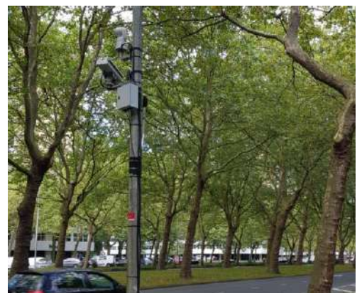
Meetpost rijbaan richting Noord
