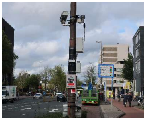
Meetpost rijbaan richting Noord
